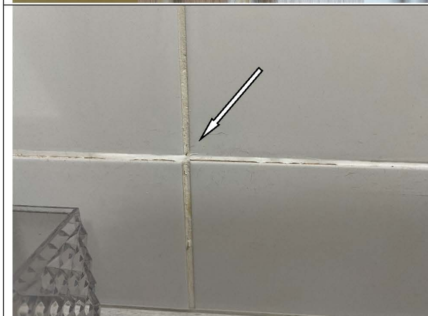
Фото №47. Затирка швов настенной керамической плитки в ванной комнате.
