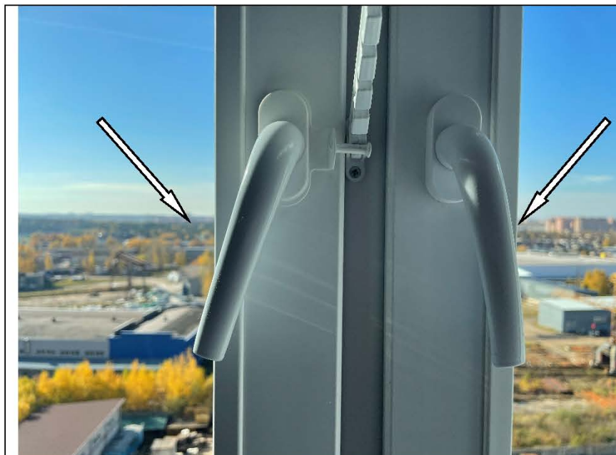
Фото №31. Фурнитура в кухне не отрегулирована.
